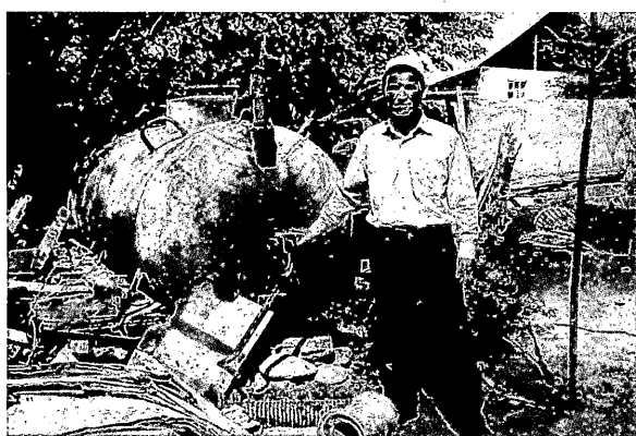
写真4 不稼働バイオガス装置
