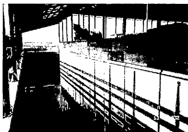
写真1 堆肥舎とれき汁貯留槽の一例
