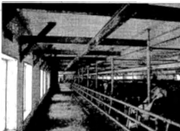
写真10 自動給餌機の走行レール
