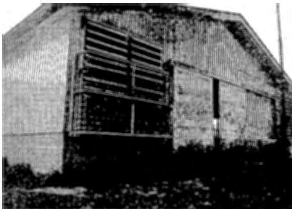
写真15 トンネル換気システム
