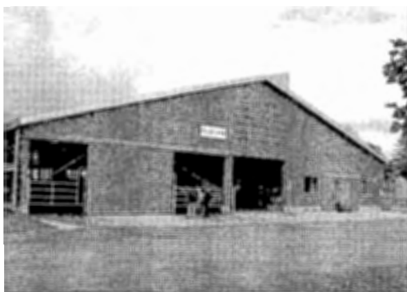
写真6 フリーストール牛舎外観
