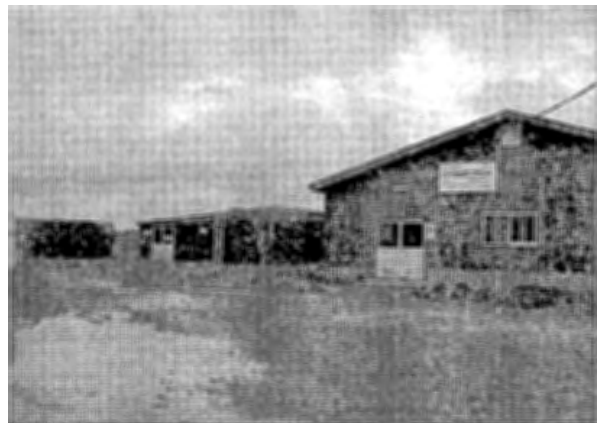
写真18 右から一時発酵槽、二次発酵槽、貯留槽
