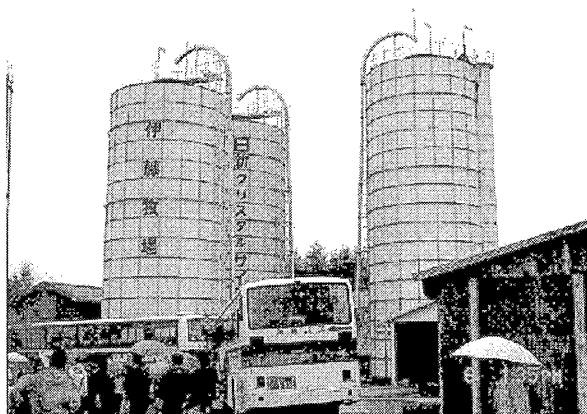
写真7 スチールサイロ（伊藤牧場）
