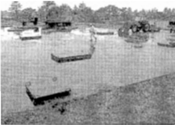
写真10 地下ピット (井出牧場)
