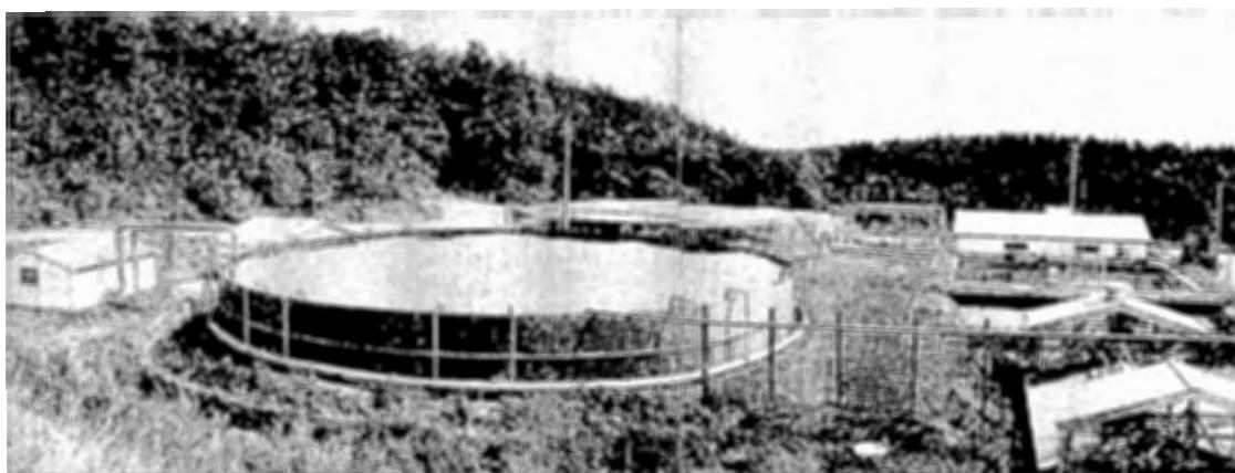
第一曝気槽・第二曝気槽・沈降分離槽
