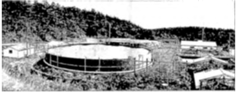
第1曝気槽・第2曝気槽・沈降分離槽
