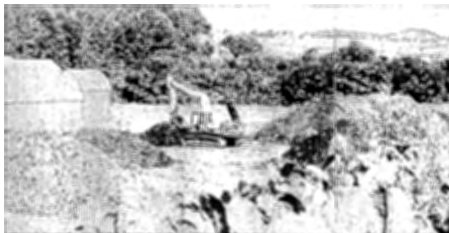
バックホーによる切り返し
