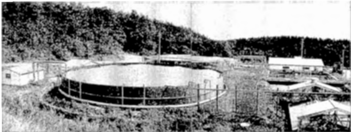
第一曝気槽・第2曝気槽・沈降分離槽
