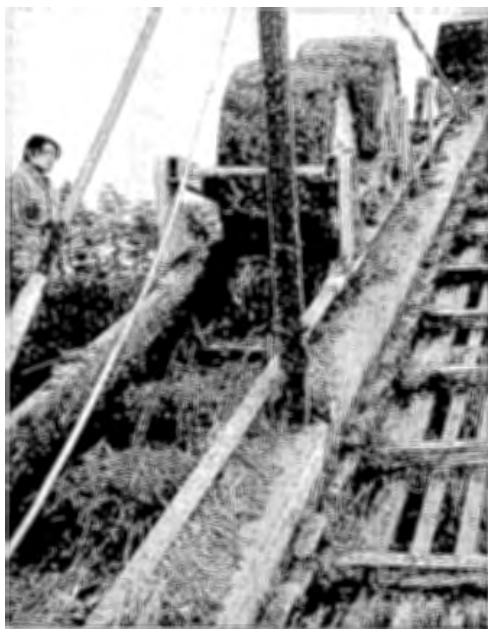
写真3 本別町(株)吉田鉄工が考案したバークリーナ用の固液分離装置、上方の二つのロールで搾る。
