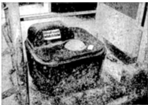
写真2 地熱利用の凍結防止型給水装置
