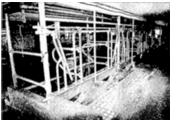
写真2. スタンション牛床を改修したアプレスト式バーラー。
