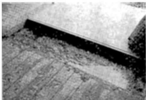
写真2 集ふん溝、敷料未使用（富士西麓地区） 水深15cmに注水後牛ふん投入、直ぐ加水
