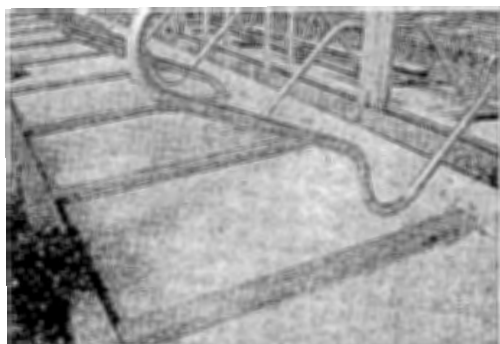
写真3 牛床の構造
