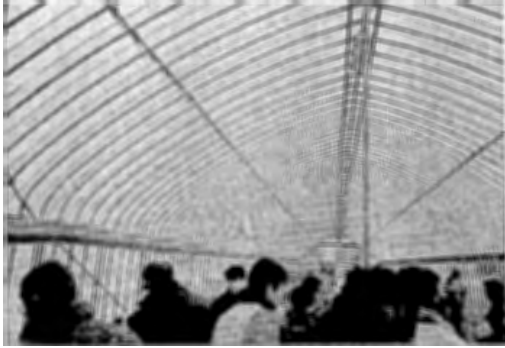
写真6. 末下牧場：哺育舎内部，中央が間柱
