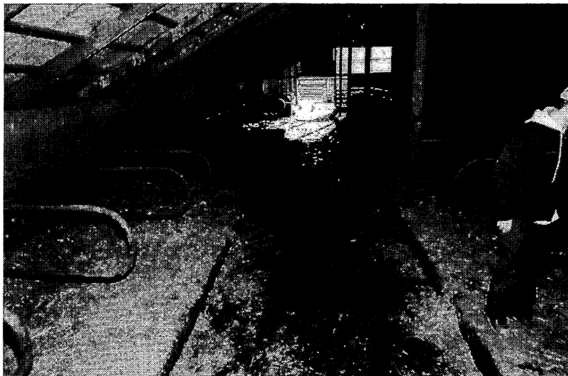
写真14 フリーストール畜舎内部 軒高が1800程度しかなく開口部が少なく暗い
