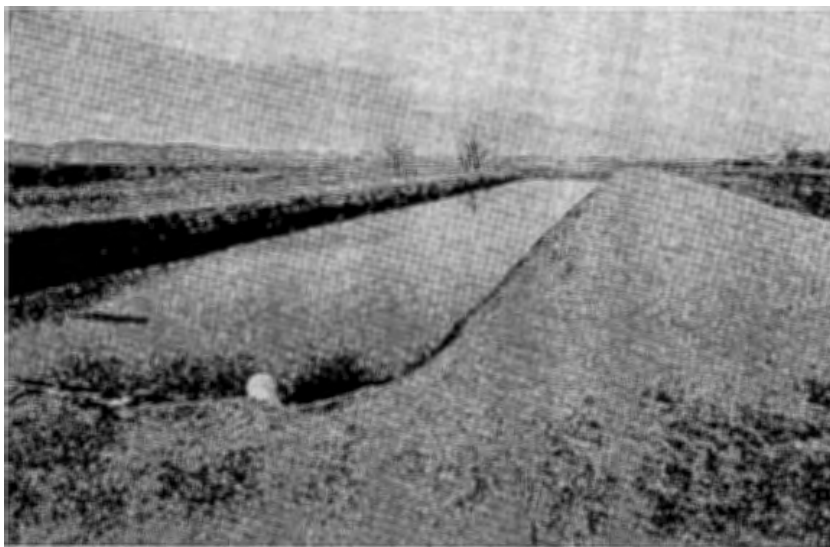
写真39 ラグウン槽 10M×50M×4ヵ所
