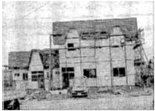
写真-4 新築中の共同浴場
