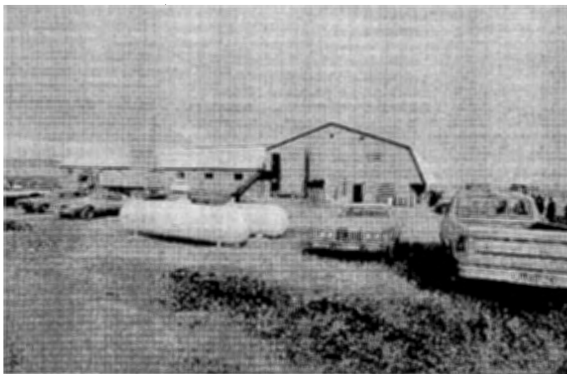
写真37 搾乳室外部全景 22tストレージタンク2基
