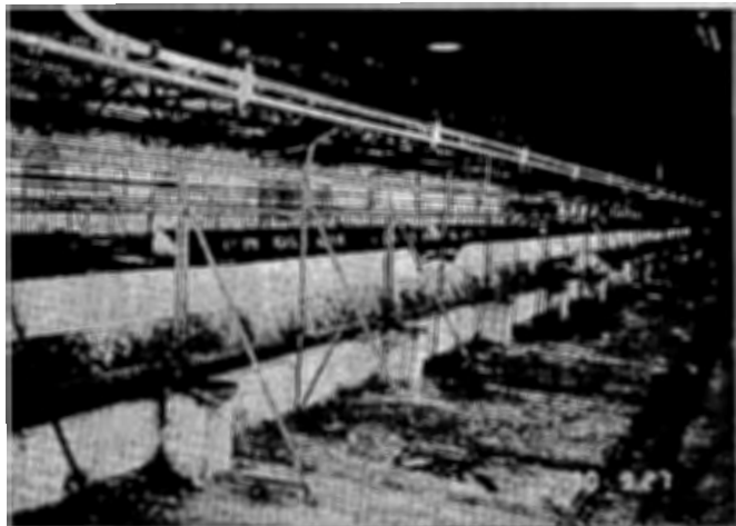
400 頭牛舎の内部 (牛床・バーンクリーナー修理 中)
