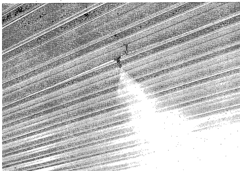
図17 冷房のためのウォーターミストシステム（ペンシルバニア）
