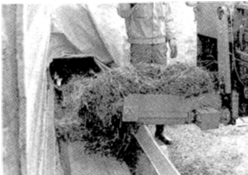
図-5 クロスコンベヤによる詰込み状況
