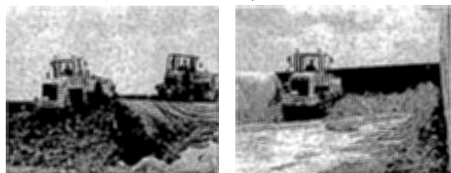
写真1 バンカサイロの2本同時詰め
