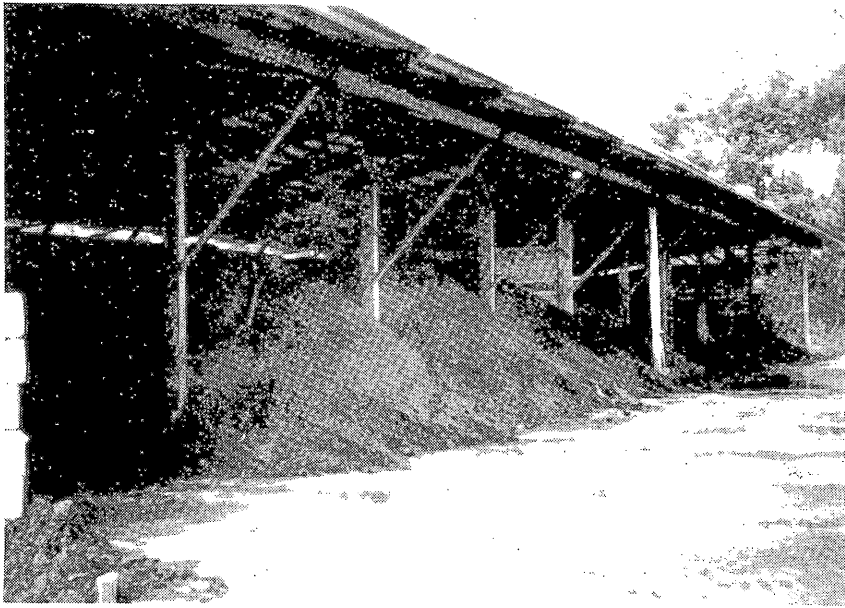
写真2. 滝川市 西谷養鶏場 鶏ふん処理場 二次発酵槽
